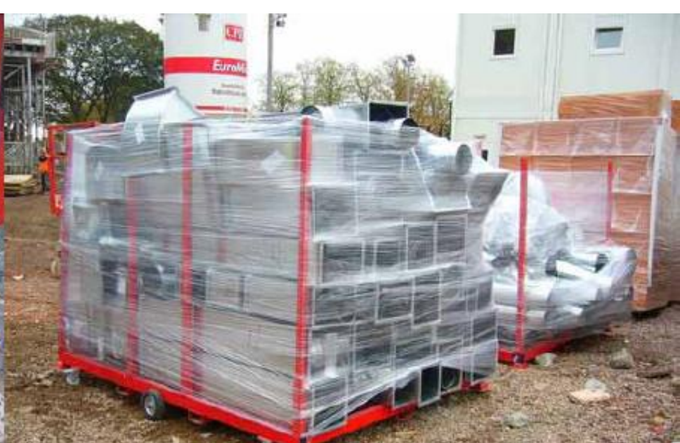
Préparation des conduits : 1 zone
