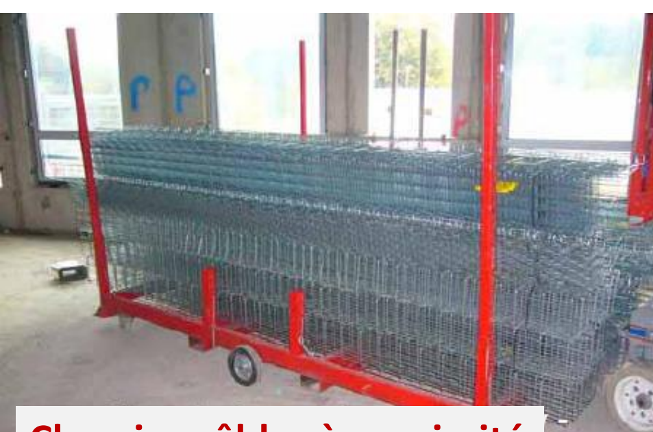
Chemins câbles à proximité
