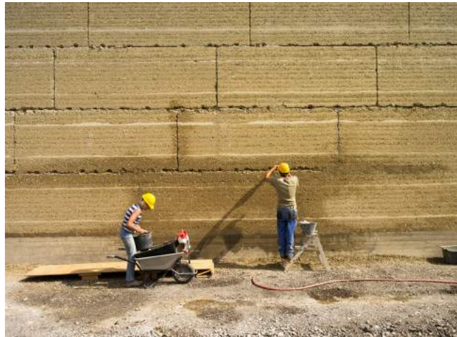
Mur en pisé préfabriqué du Ricola Kräuterzentrum (Maison des plantes) © Markus Bühler-RASOM
