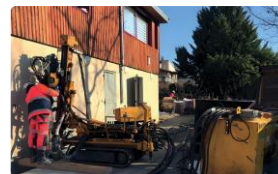
Reprises en sous-œuvre de pavillons
