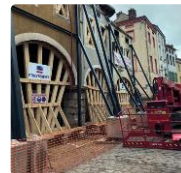
Mise en sécurité d'urgence
